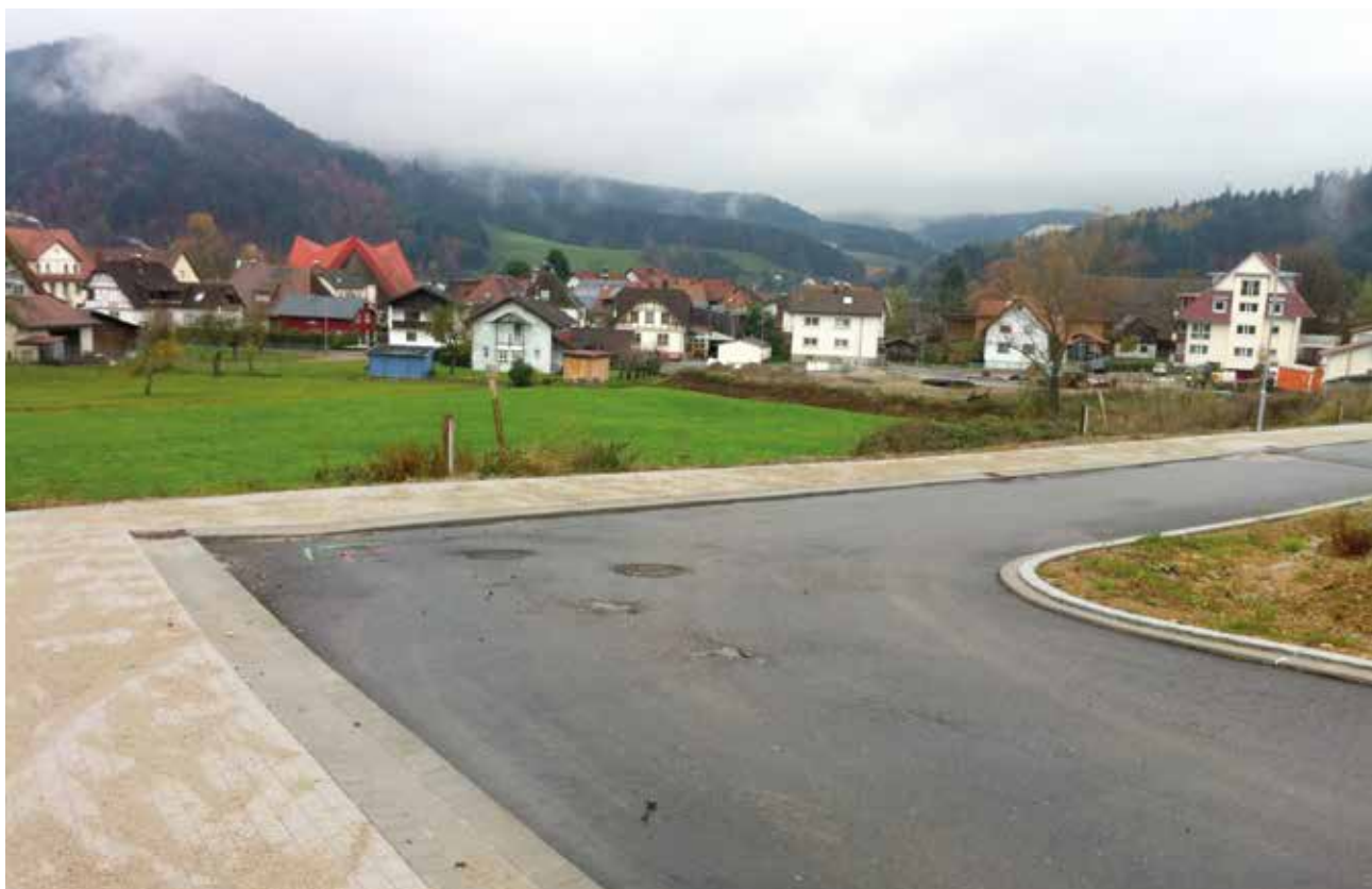
Erschließungsarbeiten zur Flächenentwicklung (Gemeinde Gutach im Breisgau)
