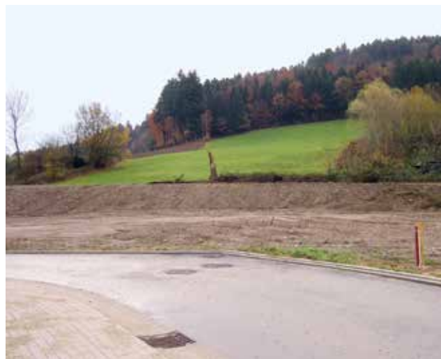
Vorbereitende Arbeiten zur Entwicklung der „Alten Ziegelei“ (FSP Stadtplanung)
