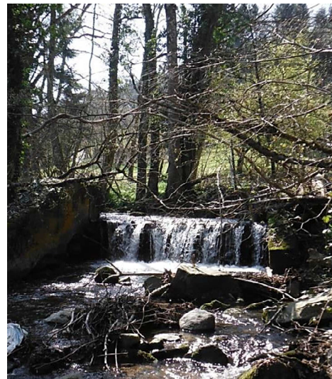
Abbildung 6: Fehlende Durchgängigkeit Bohrerbach, Standort 3d (Scheuber, 28.03.2017)
