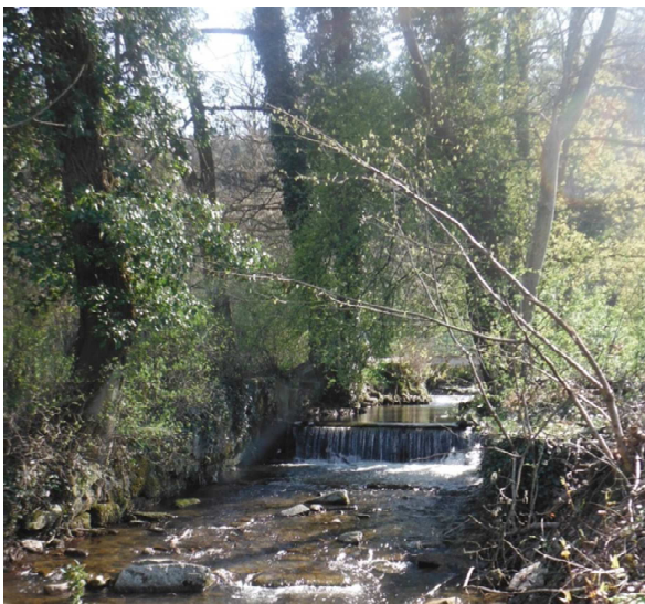
Abbildung 5: Fehlende Durchgängigkeit Bohrerbach, Standort 2a (Scheuber, 28.03.2017)
