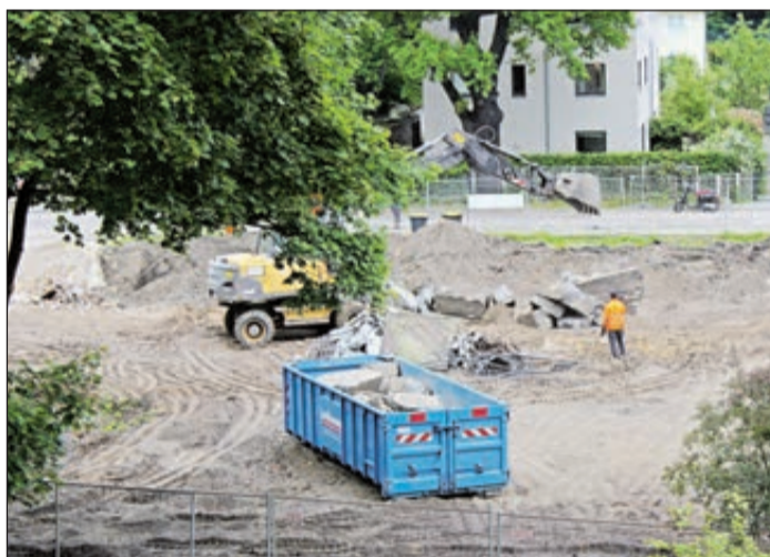
Hier soll ein neues Haus gebaut werden. Nachdem das Grundstück geräumt ist, rückt der Bagger an. Vorher sollte man wissen, wie der Baugrund beschaffen ist.
