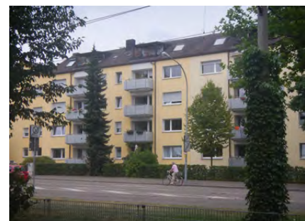
Fehrenbachallee, Dach bereits ausgebaut.
