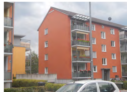
Fehrenbachallee, Dach ausbaubar.
